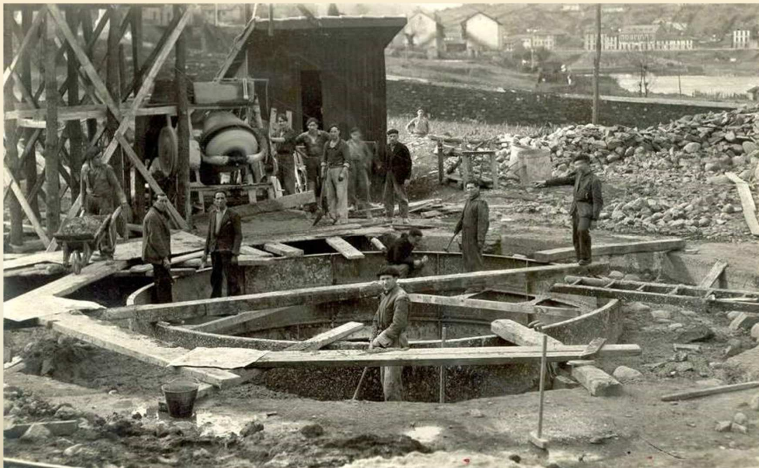
Primera cimbrada del pozo San Antonio 28 – 2 - 1941
