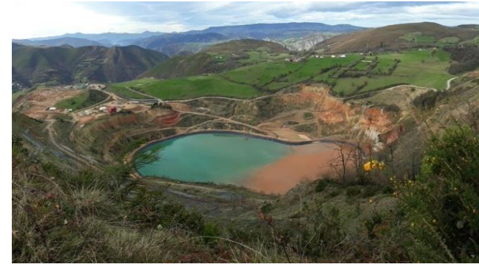
Balsa en una explotación minera activa de Belmonte de Miranda.
