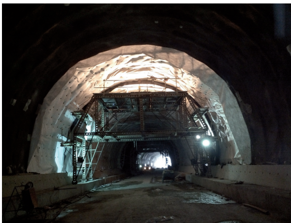
Impermeabilización Túnel Argelia 2015.
