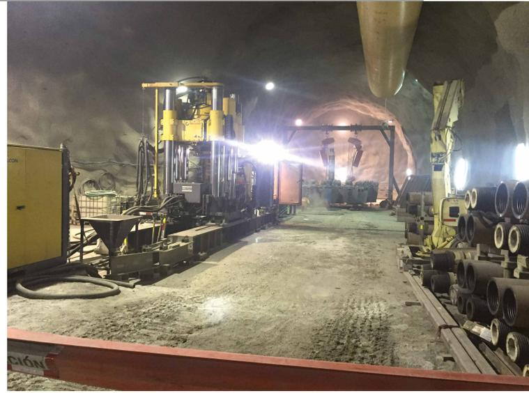
*Máquina Raise Boring para ejecución de pozos verticales y detalle de galería.*
